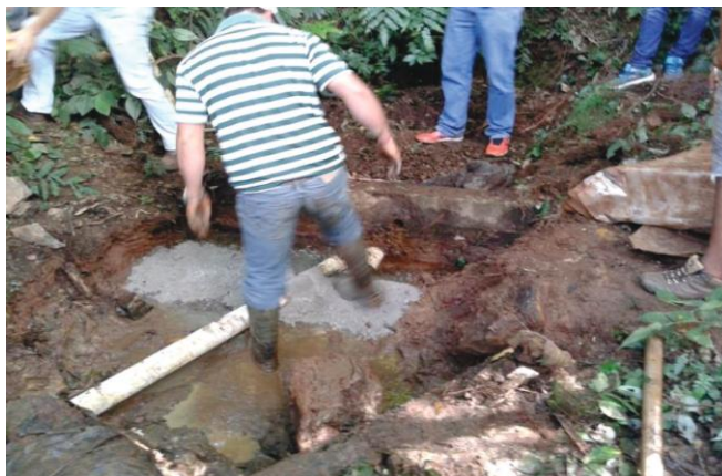
Figura 31 – Colocação de pedras e da farofa solo-cimento
