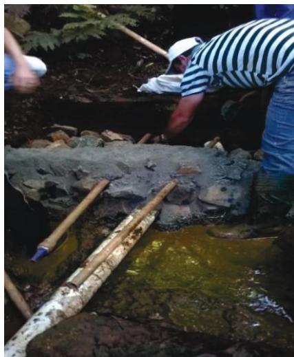
Figura 32 – Colocação dos canos da saída d'água
