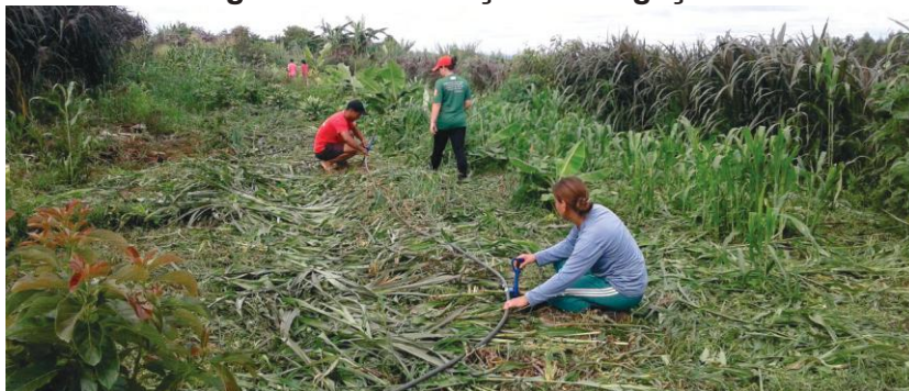
Figura 40 – Instalação da irrigação
